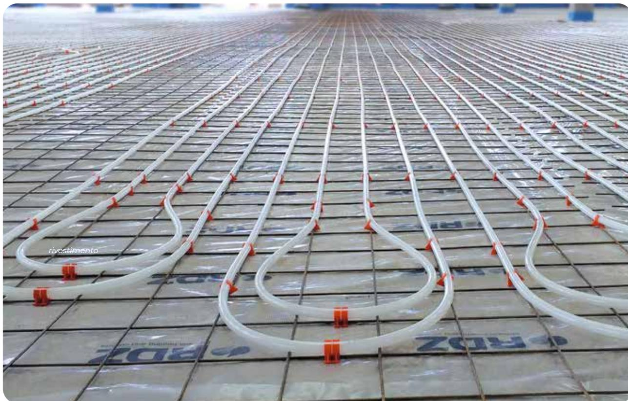
El sistema **industrial sobre malla** es una solución para la calefacción de suelo radiante de edificios industriales caracterizada por tuberías ancladas a la malla mediante clips y ahogadas en el hormigón.
